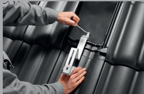
Regulowane haki dachowe do montażu na dachu.
