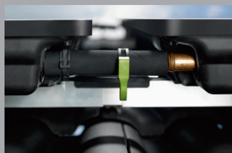
Wąż solarny i und opaski z taśmy sprężynowej przy Logasol SKN4.0.
